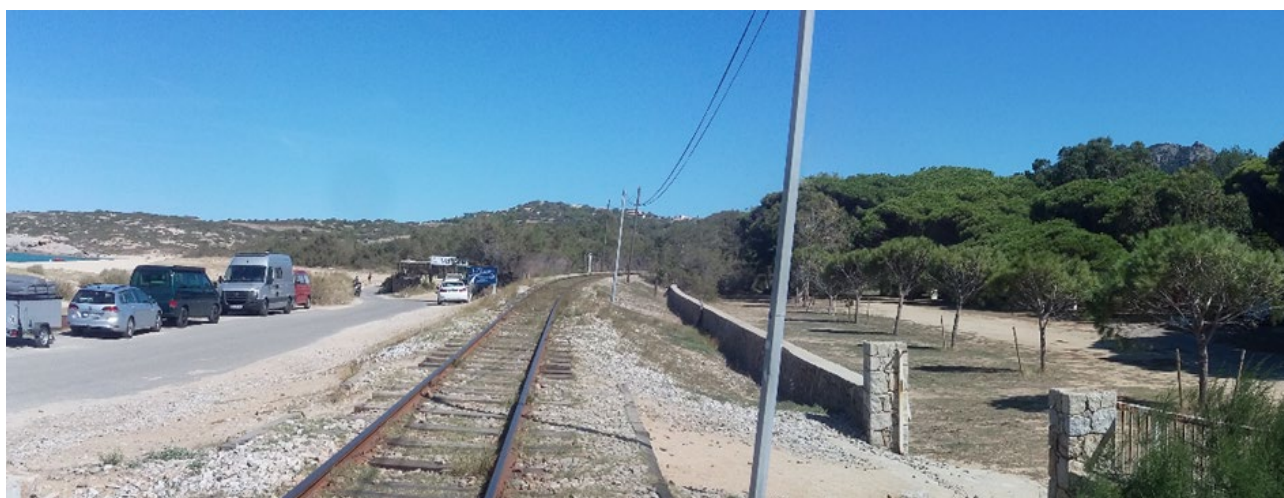
Le boulevard littoral d'Algajola et la voie ferrée
