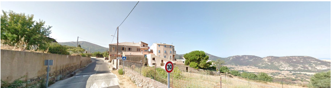
La RD151, en entrée du hameau de Praoli
